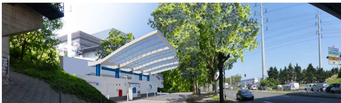
Image 4 : Station hydrogène (façade est de l'installation) source : Atelier des paysages
